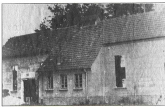
Der alte Lokschuppen im Jahr 1952. Aus diesem Gebäude entstand das Hotel Mittwald.
